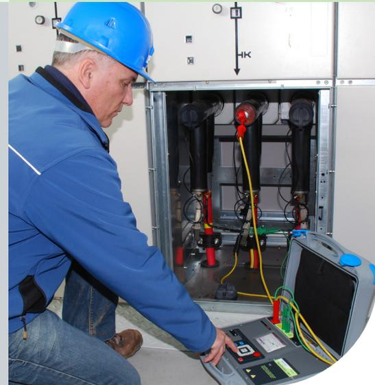
**MI 3210 TeraOhm XA 10kV ist ein tragbares, netz- oder batteriebetriebenes Prüfgerät mit einem hervorragenden IP-Schutz (IP65), das für die Diagnose des Isolationswiderstands unter Verwendung von hohen DC-Prüfspannungen bis zu 10 kV bestimmt ist. Wegen seiner Robustheit (CAT IV-Schutz) und hohen Störfestigkeit gegenüber ausgestrahlten Hochfrequenzfeldern ist es bestens für den Einsatz im industriellen Umfeld geeignet.**
